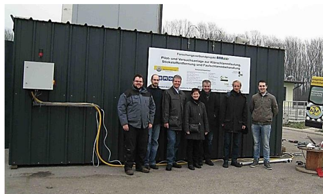
Pilotanlage am Standort Kläranlage Tulln (2012/13): Containeranlage mit 2 Faultürmen á 2 m 3 Volumen, Faulschlamm-Stripp-Anlage 1,5 bis 5 m 3 /h, 3 gerührte Schlammbehälter, manuelle Schlammpresse
