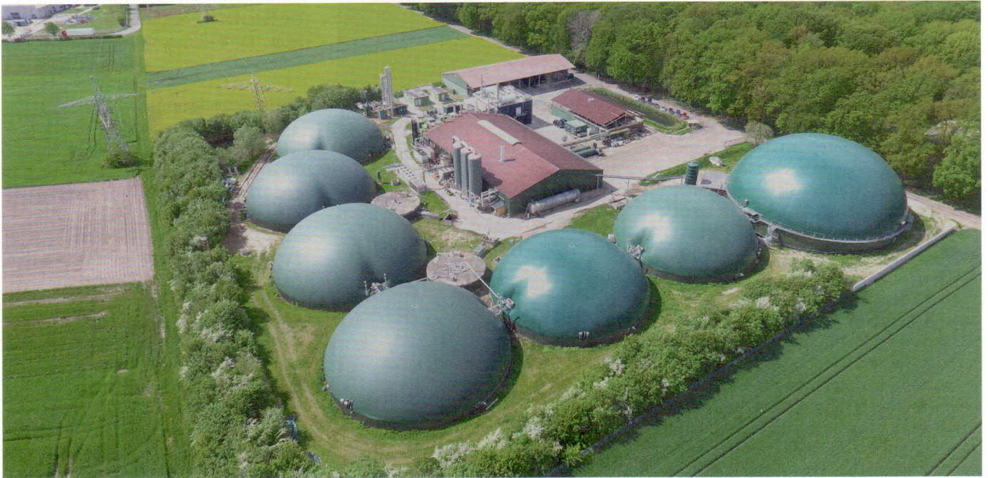
Im niedersächsischen Ottersberg werden aus Bioabfällen und Gärrückständen wertvolle Mineralien wie Phosphor und Stickstoff sowie Biofasern gewonnen.
